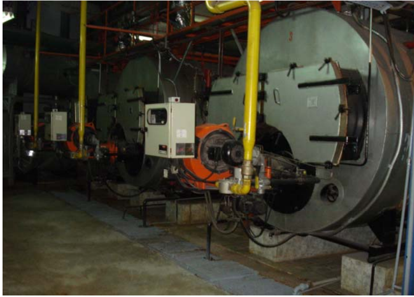
Şekil 5.2 Koruma programı uygulanan buhar kazanları
