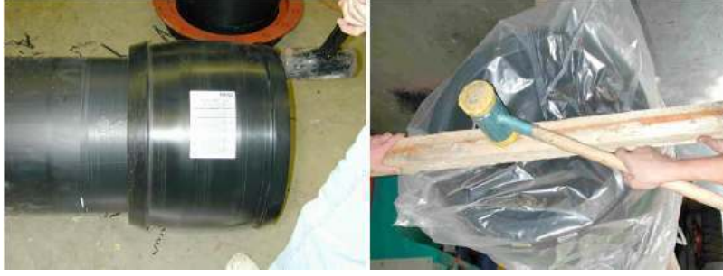
Şekil 3.9 Borunun manşon içerisine tam olarak yerleştirilmesi
