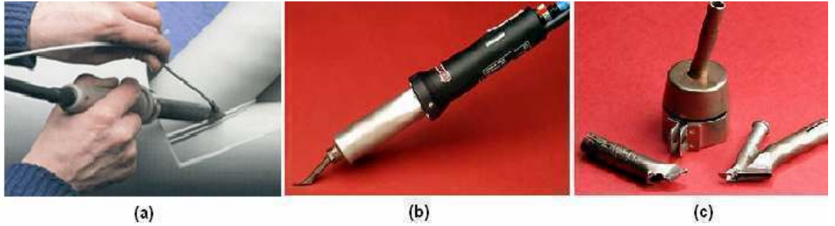
Şekil 2.4 (a) Sıcak gaz kaynağının uygulaması (b) torç (c) nozul
