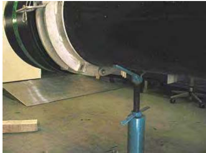
Şekil 3.10 Kaynak sırasında malzemelerin desteklenmesi
