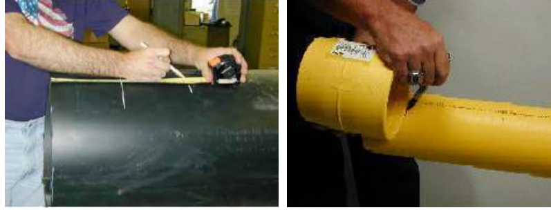
Şekil 3.5 Borunun manşon içine sürüleceği derinliğin üzerinde işaretlenmesi
