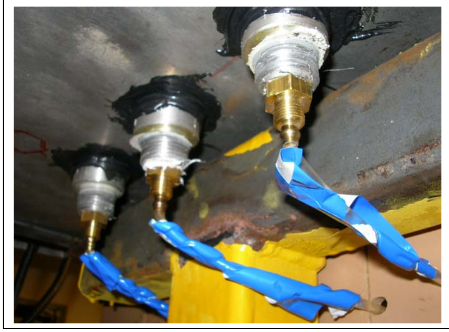
Şekil 4.7 Su haznesi çıkış bağlantıları
