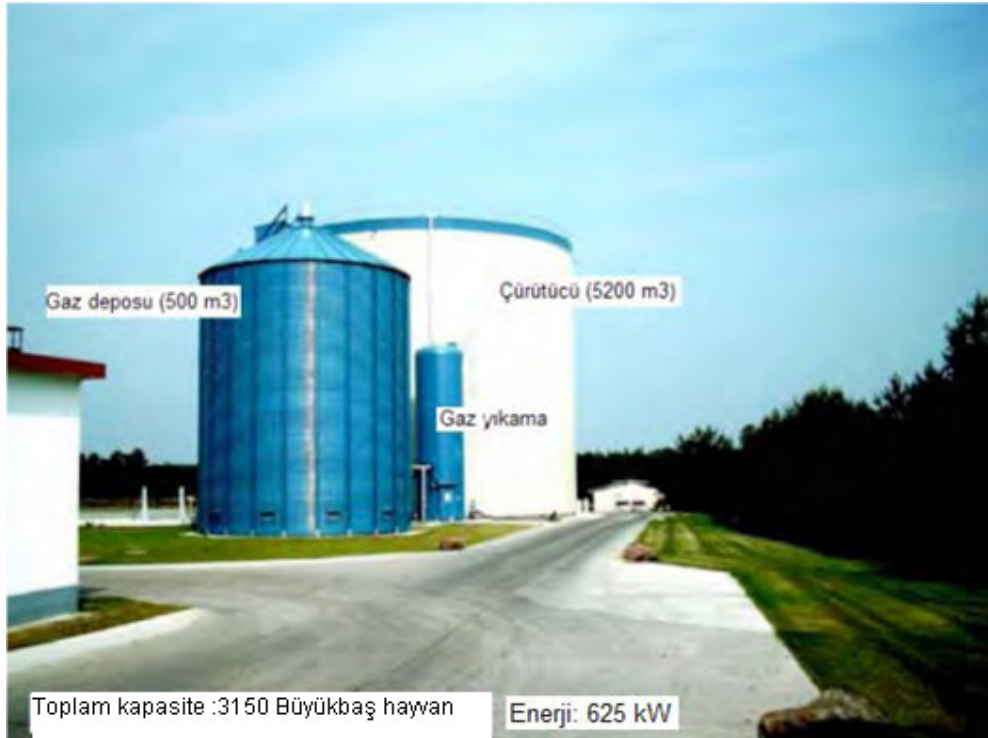
Şekil 9.4 3150 Büyükbaş hayvan kapasiteli bir uygulama tesisi (www.detesenergy.com)
