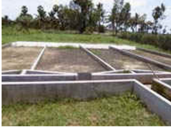
Şekil 4.5 Gübrenin beton havuzlarda kurumaya bırakılışı (Bilgin, N. 2003)
