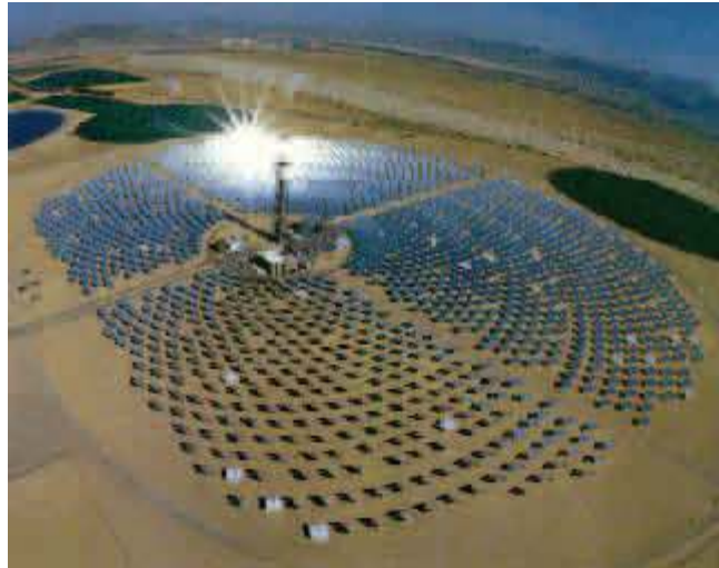
Şekil 2.2 Güneşten elektrik üretim istasyonu(Anonim,2005-b)
