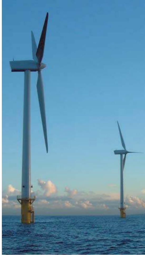
Şekil 2.4 Deniz kıyılarına inşa edilen rüzgar türbinleri (Bilim ve Teknik, Mart 2004)
