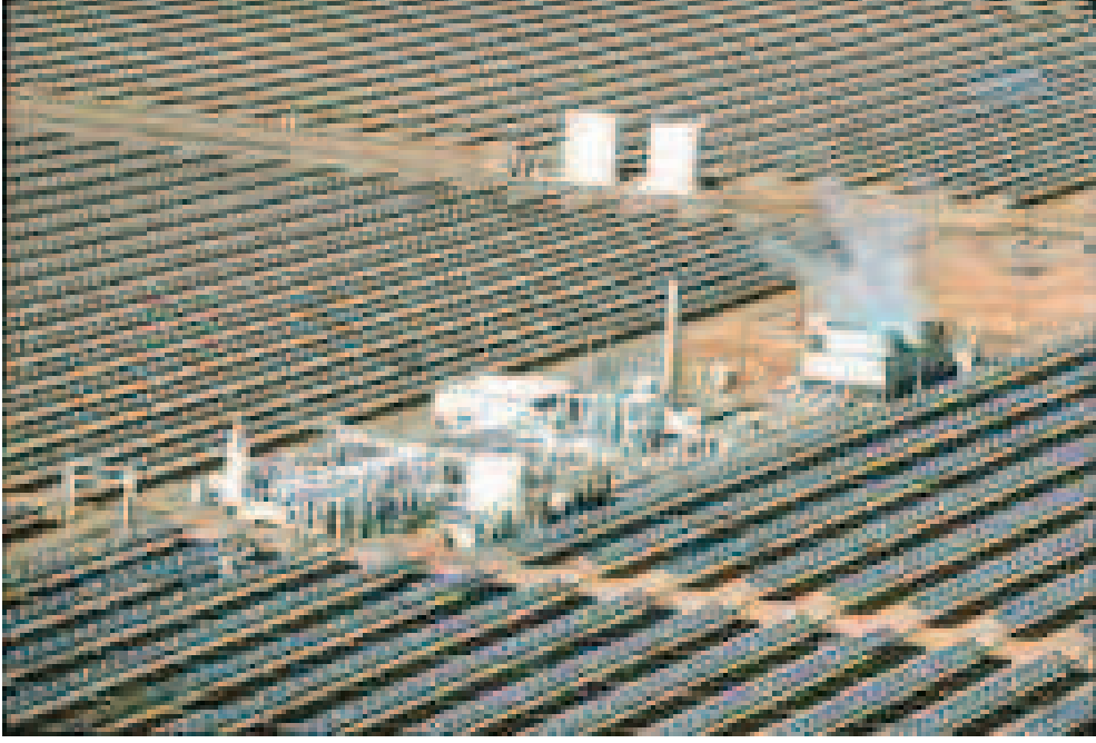
Şekil 4.1 SEGS VI elektrik santrali (Stoddard ve Abiecunas, 2006)
