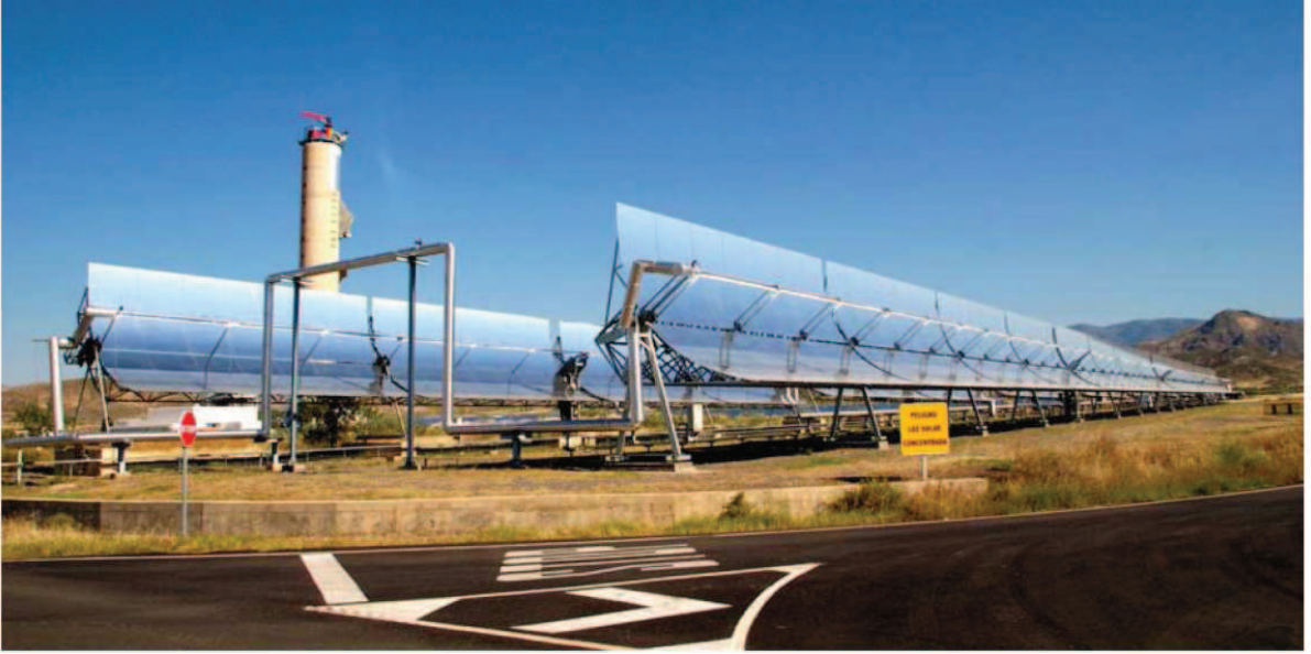
Şekil 3.15 Parabolik oluk sistemli güç santrali (Plaza, 2007)
