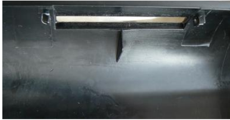
Şekil 16.38. Federin olduğu bölgedeki plastik et kalınlığının artışı gösterilmiştir.
