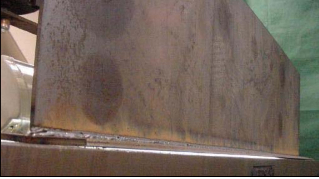
Şekil 5.31: Deney 1’de yapılan kaynak sonucu oluşan konstrüksiyon. Boyuna eğilme resimde belli olmaktadır.
