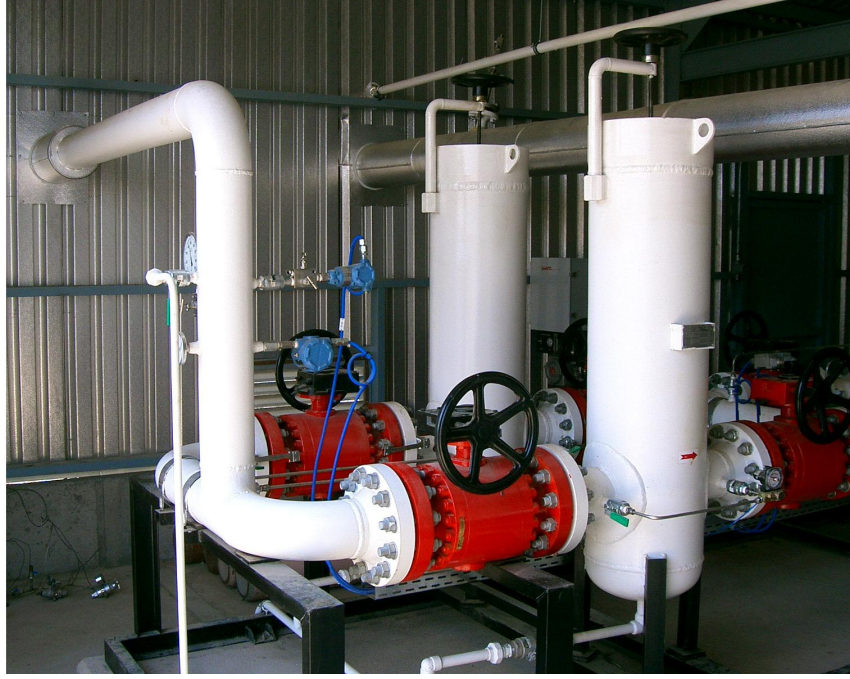
Şekil 3.7 RM-A istasyonu filtresi.
