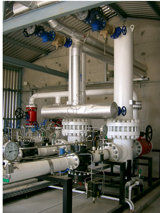
Şekil 3.10 RM-A istasyonu eşanjör ve regülatörü.
