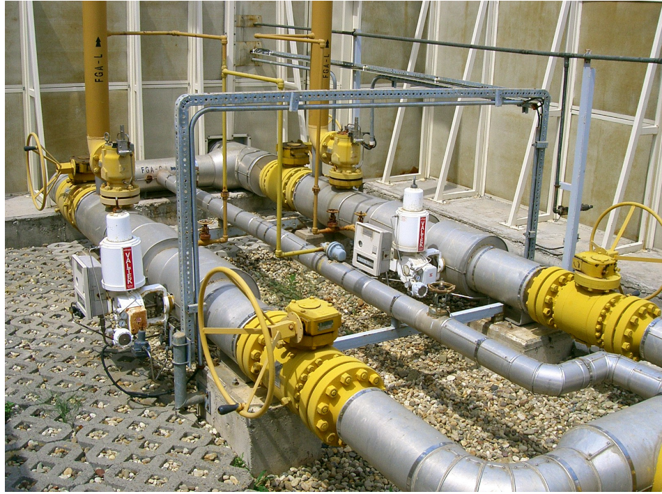
Şekil 5.5 Basınç düşürme istasyonu.
