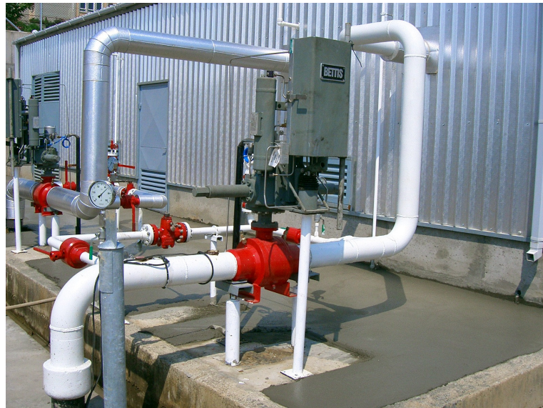
Şekil 3.6 RM-A istasyonu giriş vanası.
