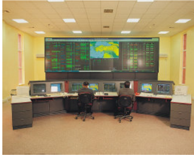
Şekil 2.2 Yapracık ana kontrol merkezinden görünüm.
