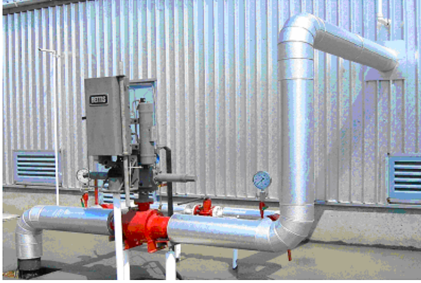
Şekil 3.13 RM-A istasyonu çıkış vanası.
