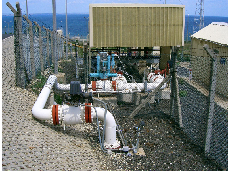
Şekil 5.3 Ölçüm istasyonu çıkışı.
