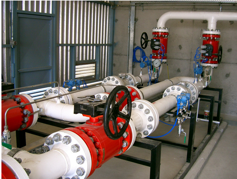
Şekil 3.8 RM-A istasyonu ölçüm hattı ve sayacı.
