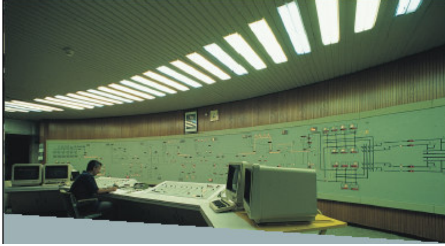
Şekil 2.1 Yapracık ana kontrol merkezinden görünüm.
