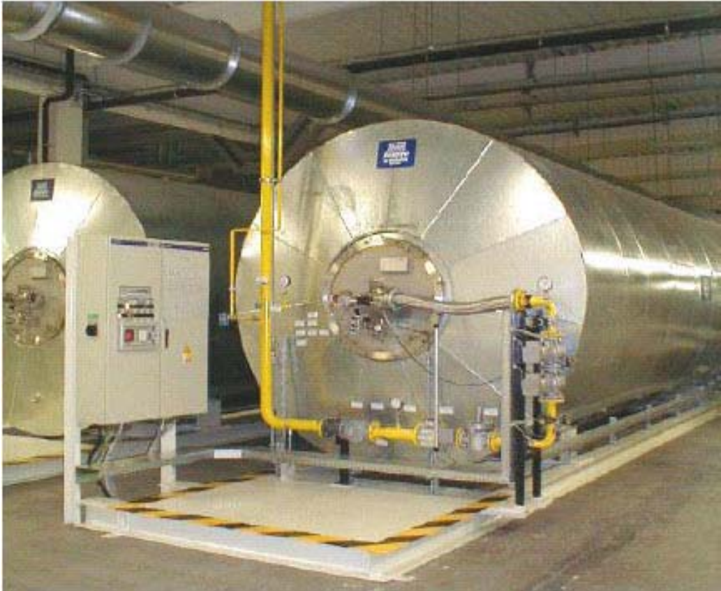
Şekil 4.6 Rejeneratif termal insineratörün uygulama örneği
