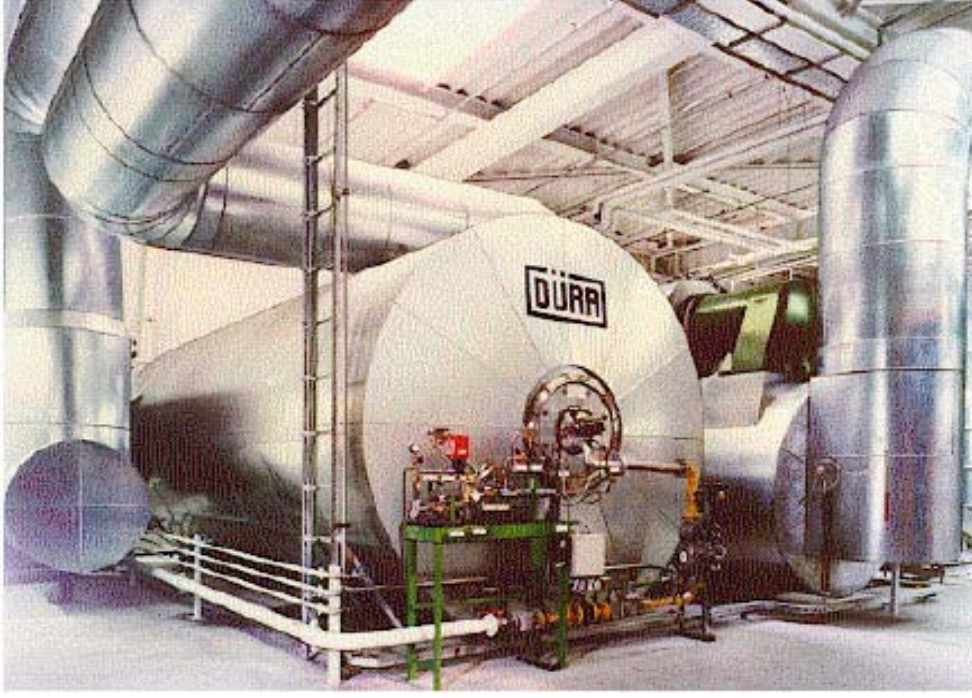
Şekil 4.8 Boya kurutma fırını baca gazlarını yakmada kullanılan bir başka termal insineratör cihazı ve sıcak hava kanalları (Dürr Environmental Technology, 2005)
