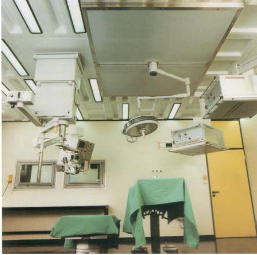
Şekil 20: Ameliyat masası aydınlatması entegre edilmiş laminar akış ünitesi (Bölüntülü – İki Parçalı Tip)
