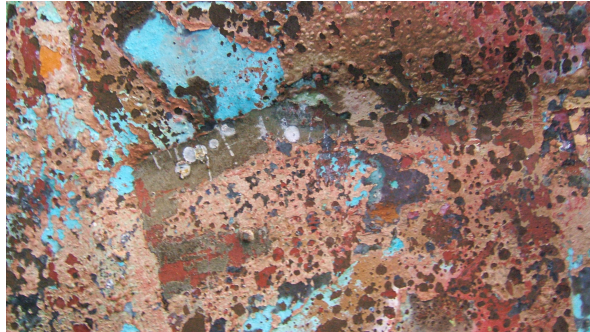
Şekil 6.7 Geminin karina bölgesinde korozyona uğrayan sac
