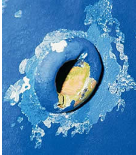
Şekil 2.11 Gemilerdeki boru tesisatında erozyonlu korozyon [11]
