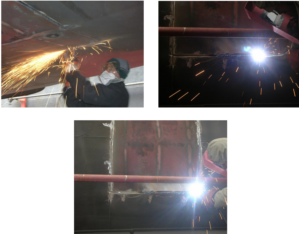
Şekil 6.16 Sacların kaynakla birleştirilme işlemleri
