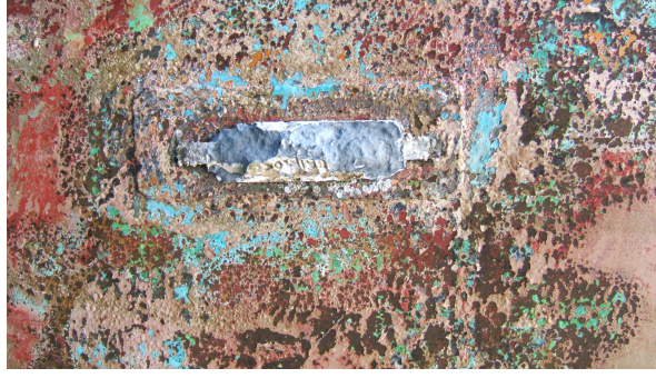
Şekil 6.5 Geminin karina bölgesine yerleştirilmiş tutya
