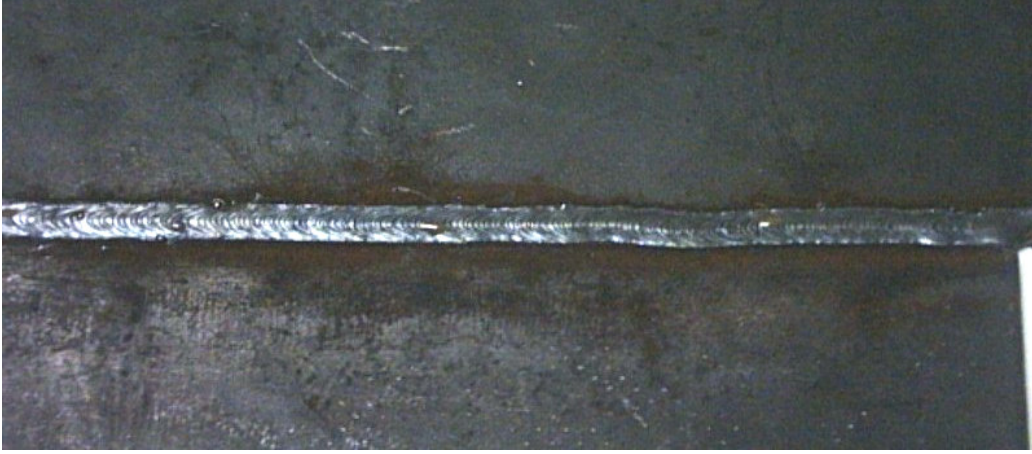
Şekil 3.14 Kaynak uygulaması (w2)
